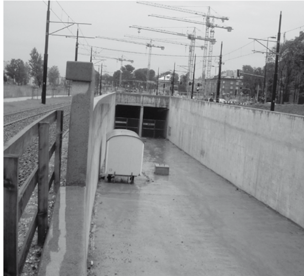
Przyszły tunel tramwajowy pod dworcem Kraków Główny. W tle budowa dzielnicy Nowe Miasto. (AB)
