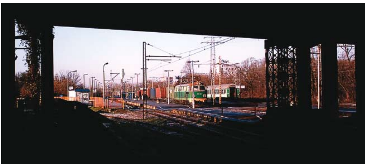
Perony dworca Warszawa Gdańska – widok z przejścia pod wiaduktem. (WS)
