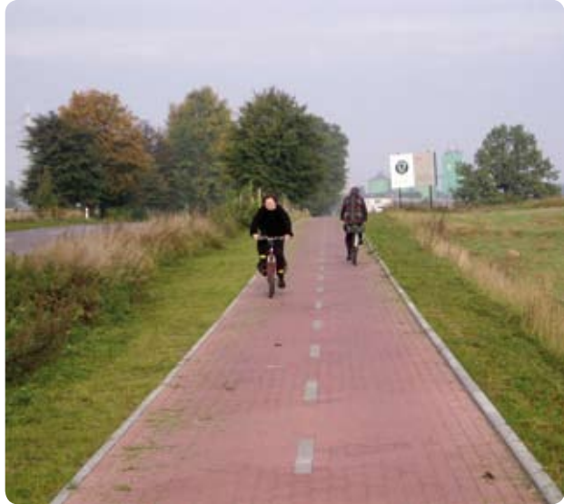
Wspólny ciąg pieszo-rowerowy ma zastosowanie poza terenem zabudowanym, gdzie natężenie ruchu pieszego jest niewielkie. Na zdjęciu ciąg Suwałki - Krzywe wzdłuż drogi wojewódzkiej nr 653. (AB)
