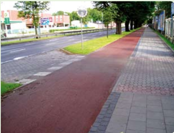
Droga rowerowa wzdłuż al. Grunwaldzkiej w Gdańsku. Warto zwrócić uwagę na strukturalne oddzielenie od chodnika oraz zachowanie ciągłości nawierzchni drogi na wjeździe bramowym. (AB)
