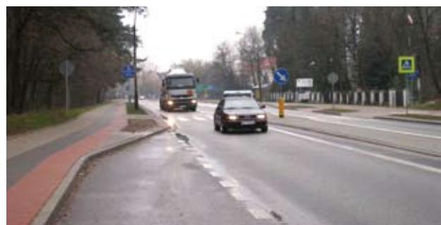
Obecnie jego szanse są o wiele większe. Wszystko dzięki asylowi na środku jezdni zwężonej do jednego pasa ruchu w każdym kierunku. Zaoszczędzoną przestrzeń wykorzystano do fizycznego oddzielenia przeciwnych kierunków ruchu, eliminując niebezpieczne zachowania kierowców. (RM)
