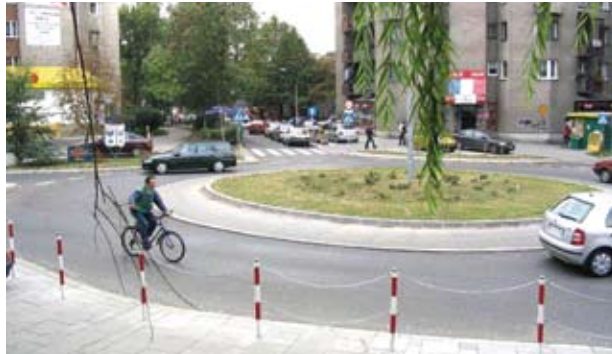
...i małe ronda są ważnymi elementami uspokojenia ruchu do wygodnego dla pieszych, kierowców i rowerzystów TEMPA 30. (TK)
